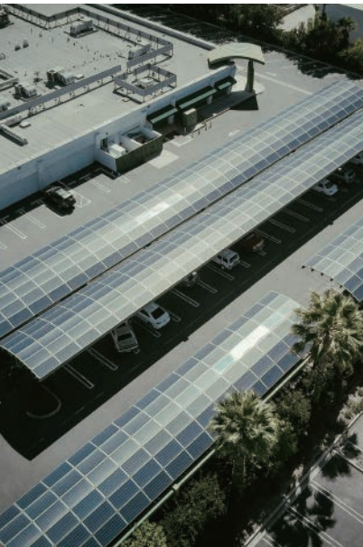
Estação de carregamento pública
