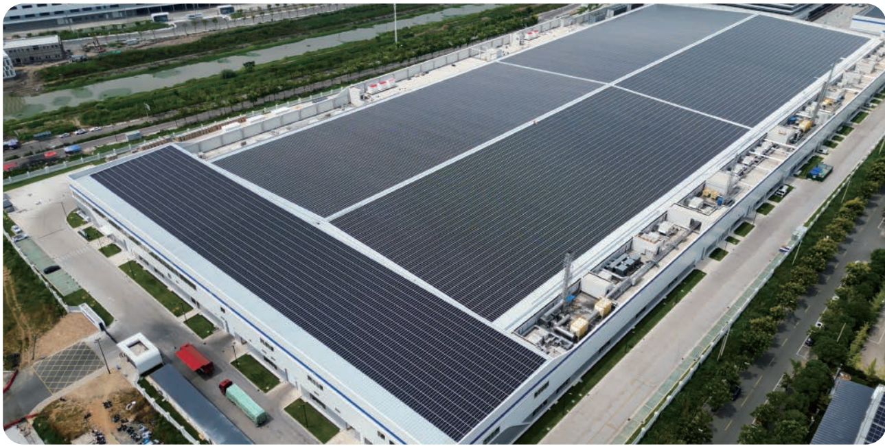
53MW Local: Zhejiang, China Data de instalação: 2024 Tipo de projeto: C&I - (BIVP)
