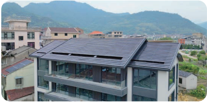
35KW Local: Zhejiang, China Data de instalação: 2023 Tipo de projeto: Residencial - (BIVP)
