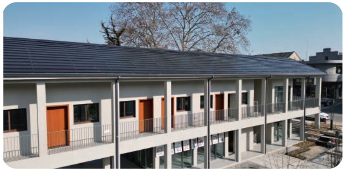
31KW Local: Nanjin, China Data de instalação: 2023 Tipo de projeto: Residencial - (BIVP)
