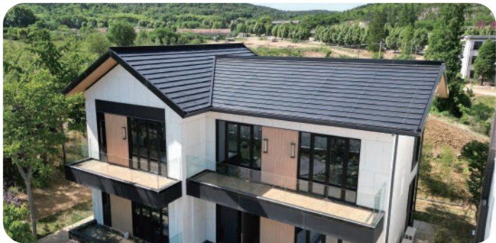
10.7KW Local: Anhui, China Data de instalação: 2024 Tipo de projeto: Residencial - (BIVP)
