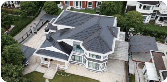
21KW Local: Shanghai, China Data de instalação: 2023 Tipo de projeto: Residencial - (BIVP)
